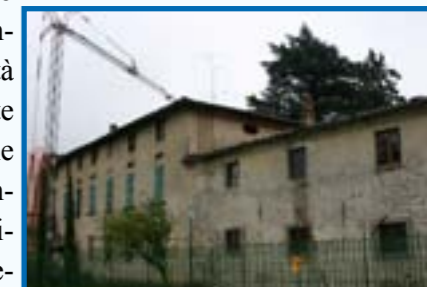
Ristrutturazione a Palazzo Ragnoli
